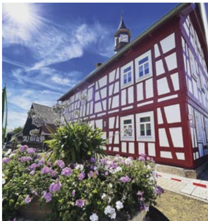
Gemeindehaus Albingshausen nach Sanierung 2023, Foto: Chr. Other
